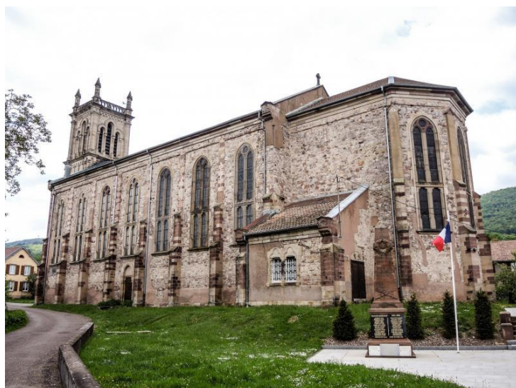
La rénovation des façades de l'église Sainte Catherine sera réalisée en 2020
